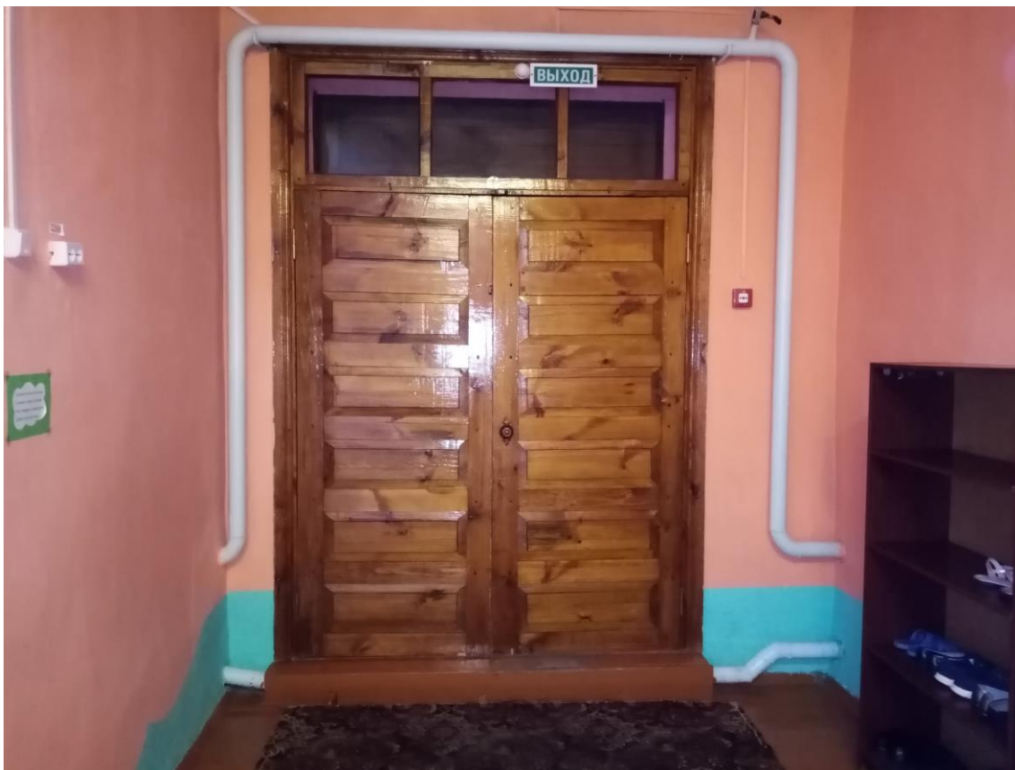
№ 11. Пути эвакуации (зоны безопасности). Дверь входная
