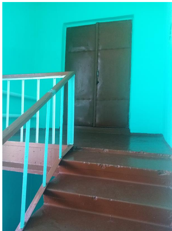
№ 15. Пути движения внутри здания. Дверь на 2 этаж
